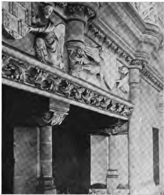
Fig. 122. — Cheminée à triple foyer du pignon de la grande salle au Palais de Justice de Poitiers. Linteaux ornés couronnant les trois foyers.
